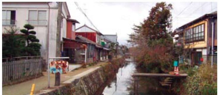
改修予定区間
