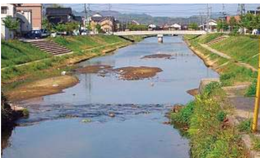
暫定改修済の下流区間
