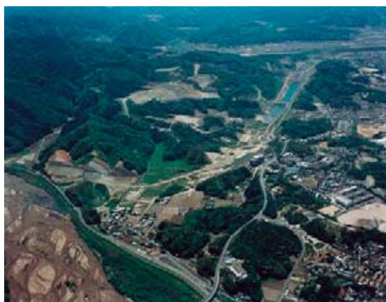
斐伊川放水路開削部 (写真手前が斐伊川、奥が神戸川)
