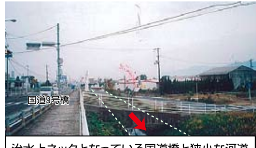
治水上ネックとなっている国道橋と狭小な河道
