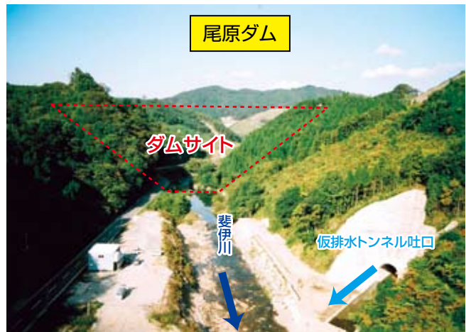
ダムサイト状況(H17年10月) (下流から上流を望む)
