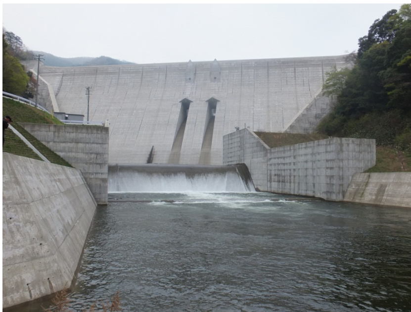
志津見ダム 16m 3 /s放流状況 (H25.4.17 16:20撮影)
