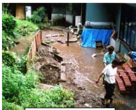
平成 18 年 7 月梅雨前線豪雨 土石流災害 (奥出雲町)
