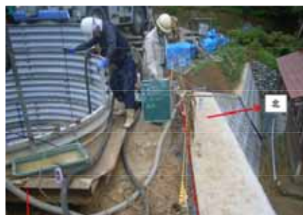
施工中の地すべり対策施設（隠岐の島町内）
