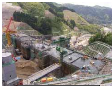
建設の進む尾原ダム (ダムサイト上流より望む)
