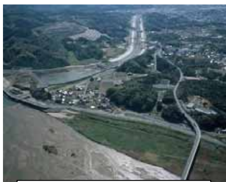
斐伊川放水路開削部 (写真手前が斐伊川、奥が神戸川)
