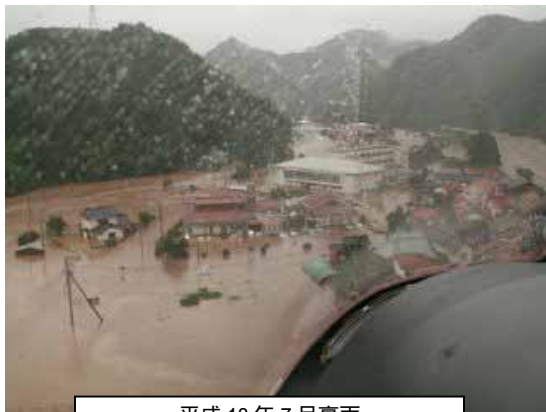
平成 18 年 7 月豪雨 氾濫した神戸川（出雲市所原地内）
