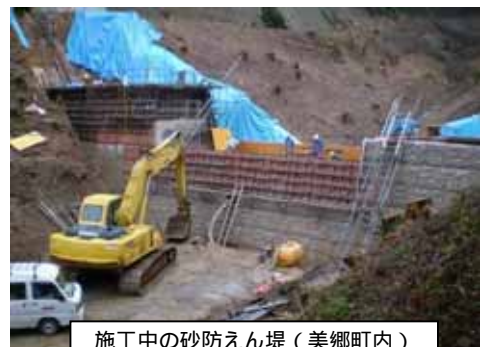
施工中の砂防えん堤（美郷町内）
