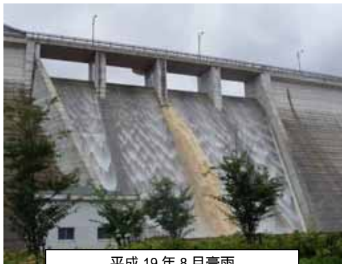
平成 19 年 8 月豪雨 銚子ダム越流状況（隠岐の島町）
