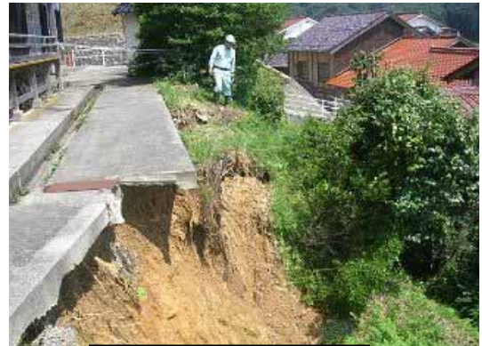
平成 18 年 7 月梅雨前線豪雨 がけ崩れ災害（江津市）
