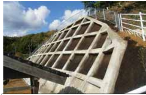
完成した急傾斜地崩壊防止施設（松江市内）
