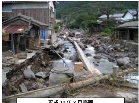
平成 19 年 8 月豪雨 土石流が発生した油井川（隠岐の島町）
