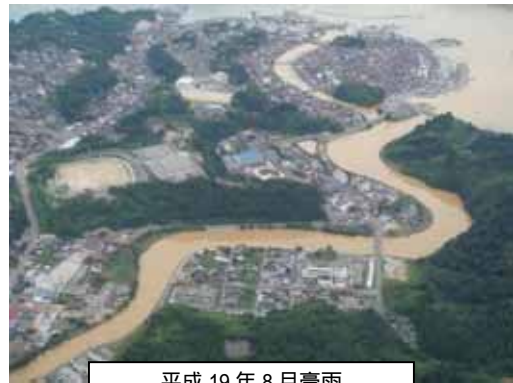
平成 19 年 8 月豪雨 八尾川放水路（隠岐の島町）
