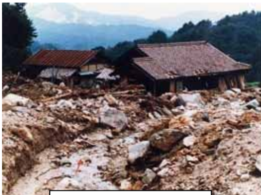
昭和 58 年 7 月梅雨前線豪雨 土石流災害 (益田市)
