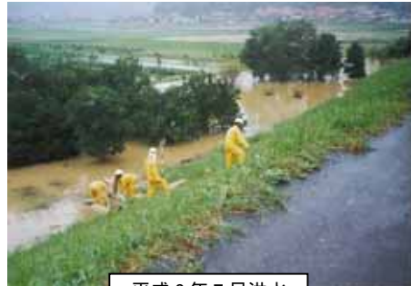
平成 9 年 7 月洪水 高津川漏水状況
