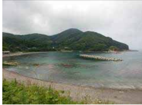
【侵食対策】美田港海岸（西ノ島町）
