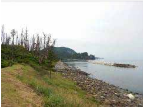
【老朽化対策】西村港海岸（隠岐の島町）
