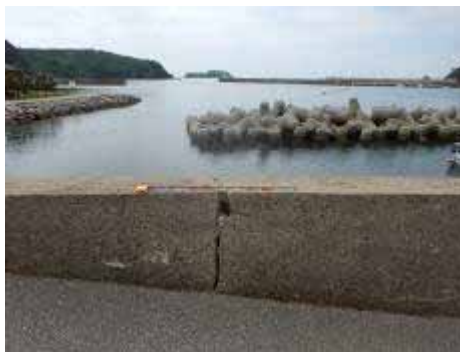
写真- 2.1 海岸保全施設の老朽化の事例
