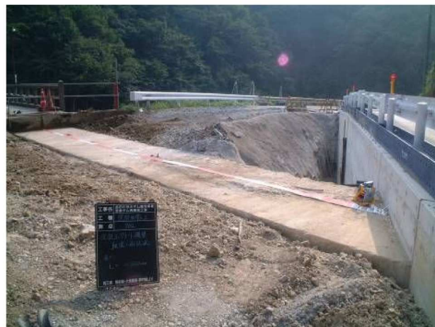
写真-10 右岸既設コンクリート壁
