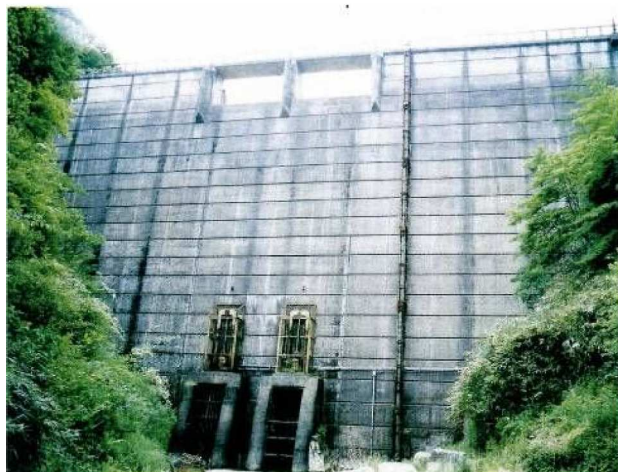
写真-3 既設堤体上流面
