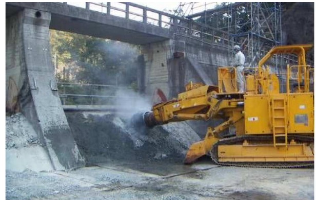
写真－4 ロードヘッダ施工状況
