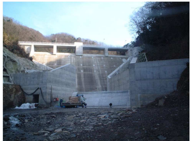
写真-13 完成後 下流面
