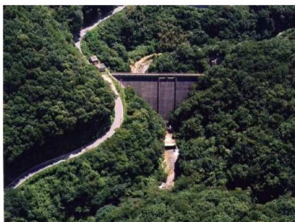
写真-1 既設ダム下流面
