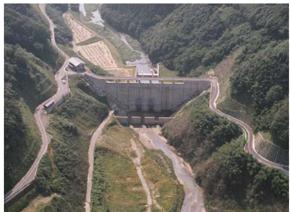
写真-3 ダム上流面
