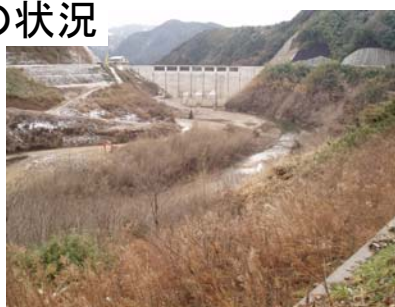
H18.02.09(試験湛水終了後)
