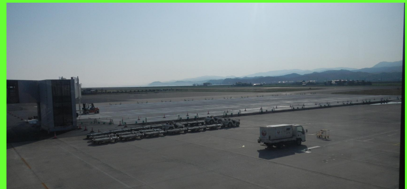
工事中の状況（平成27年3月下旬）
