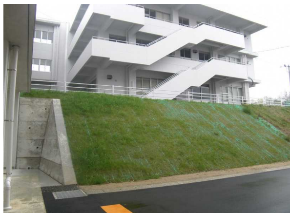
擁壁及び法面
