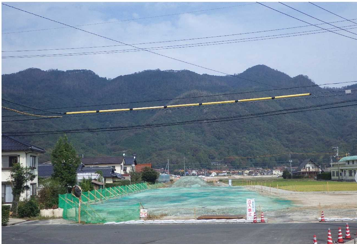
民家近接部において粉塵飛散防止のため飛散防止剤を散布
