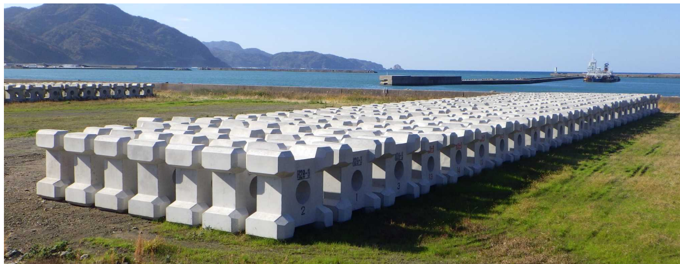
被覆ブロック製作
