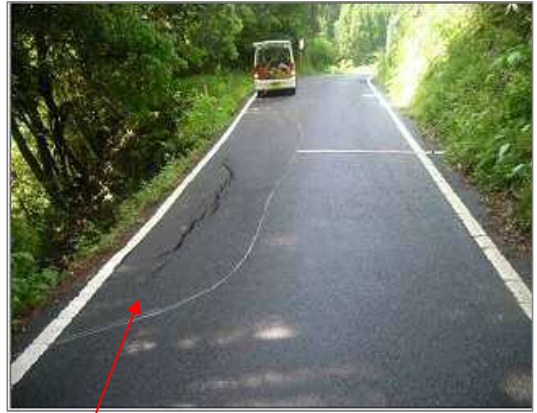
被災直後の状況
