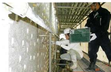
【ひび割れ注入状況 (参考写真)】
