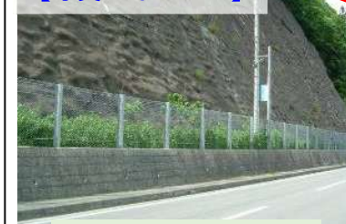
落石防護柵(杭基礎 50kJ)
