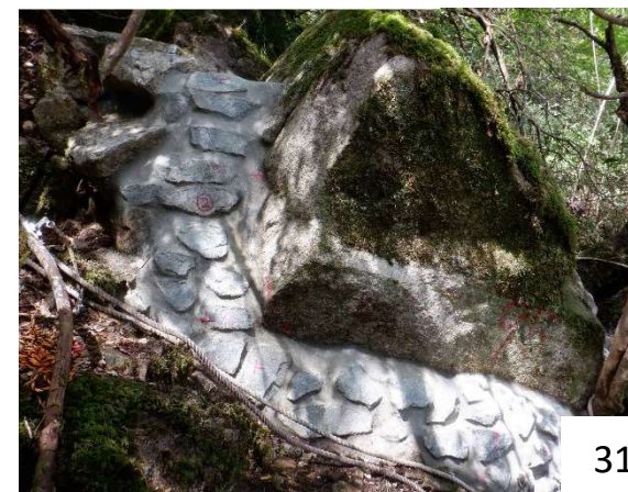
【写真：岩接着工】
