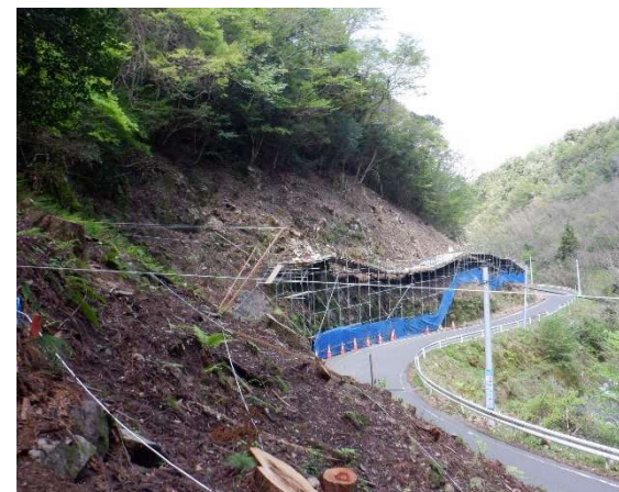
【写真：岩接着工】
