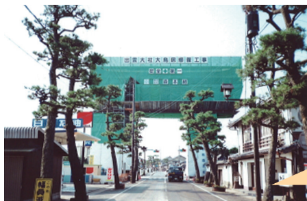
平成3年の調査・修復工事の時
