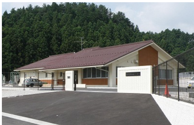
西郷浄化センター（隠岐の島町）
