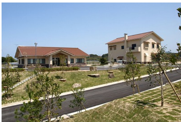
益田水質管理センター（益田市）
