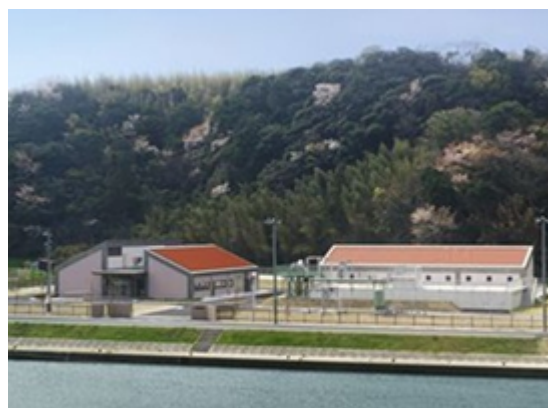
国府浄化センター（浜田市）
