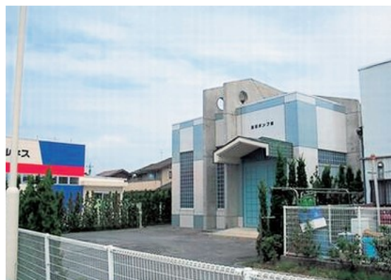
黒田中継ポンプ場（松江市）
