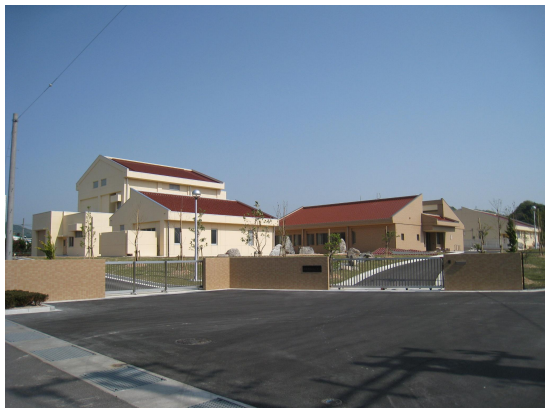
大田浄化センター（大田市）
