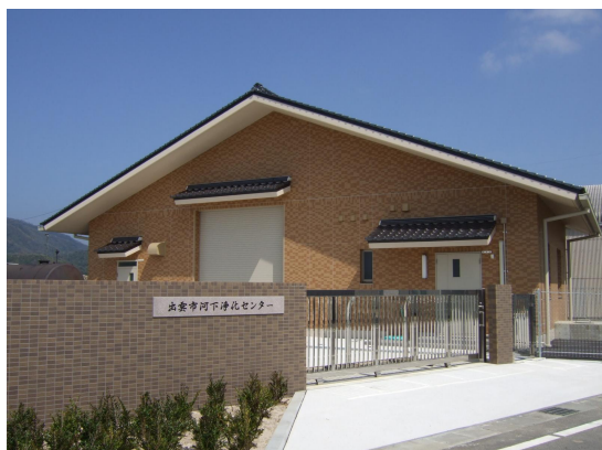
河下浄化センター（出雲市）
