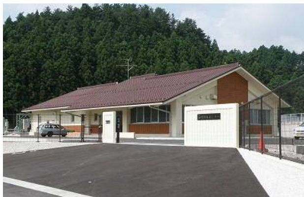
西郷浄化センター（隠岐の島町）
