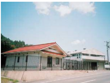
大田市リサイクルセンター（大田市）
