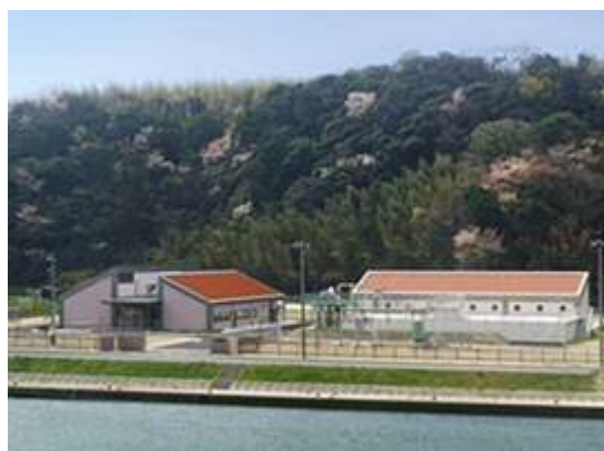
国府浄化センター（浜田市）
