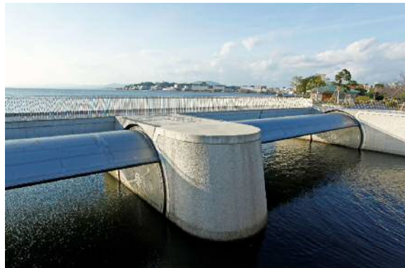
第23回大賞 「天神川水門」
