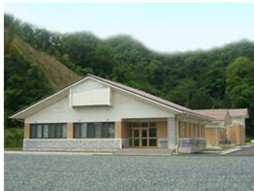
大東町浄化センター（雲南市）
