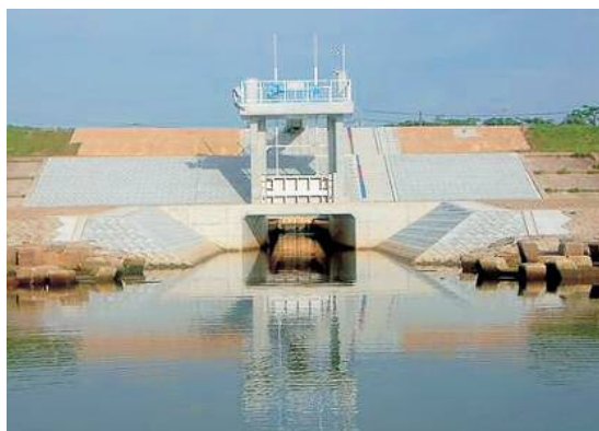
万葉都市下水道樋門（益田市）
