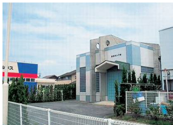
黒田中継ポンプ場（松江市）
