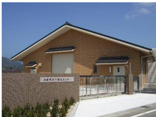
河下浄化センター（出雲市）
