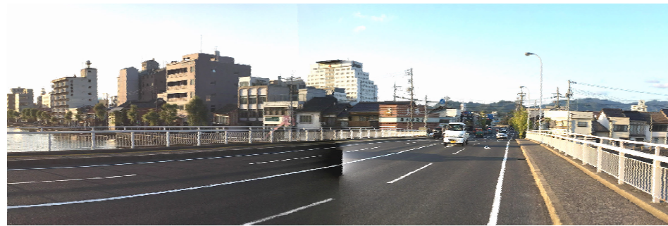
新大橋の現況
