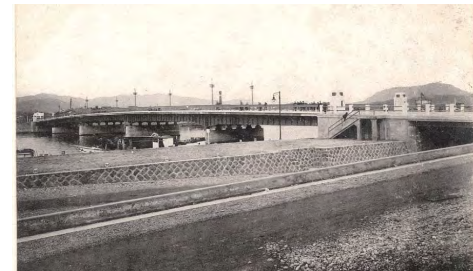
二代目新大橋 (南岸上流より)
