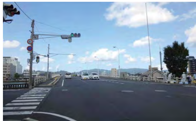
拡幅後の新大橋 (売布神社より)
