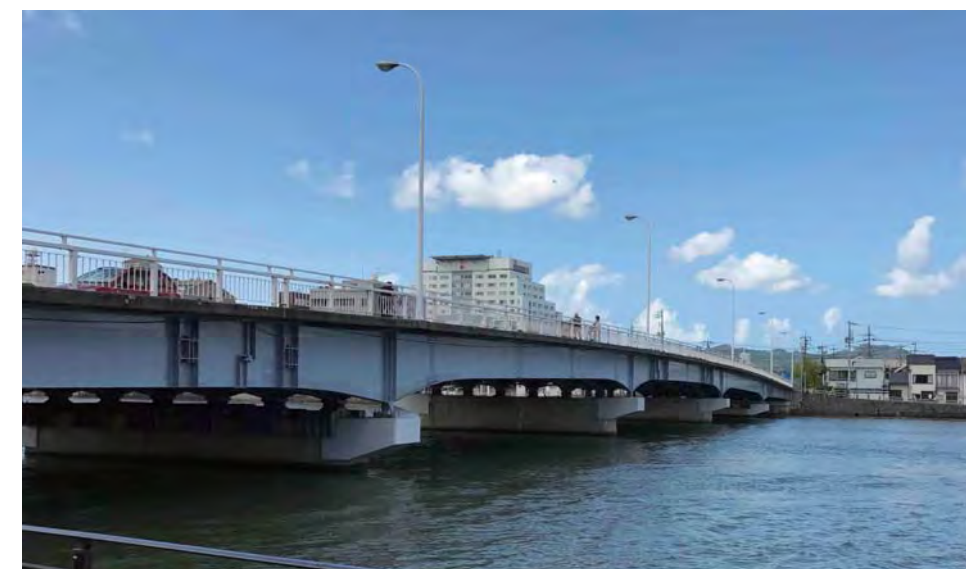
拡幅後新大橋 (南岸下流より)
