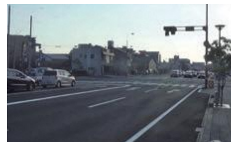
整備後（平成30年）
