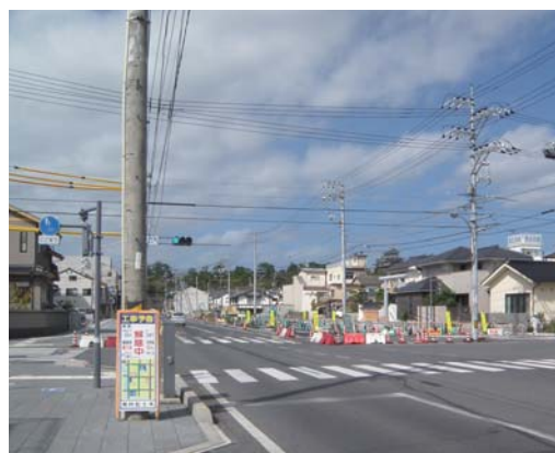
1工区の現在(平成27年10月)の状況
