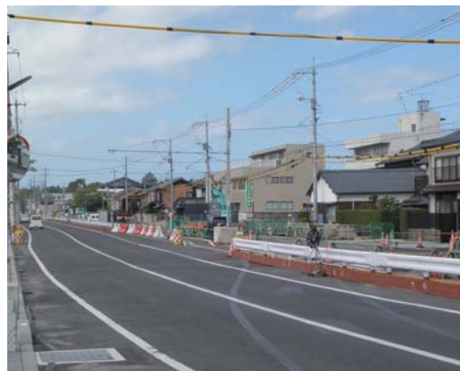
2工区の現在(平成27年10月)の状況
