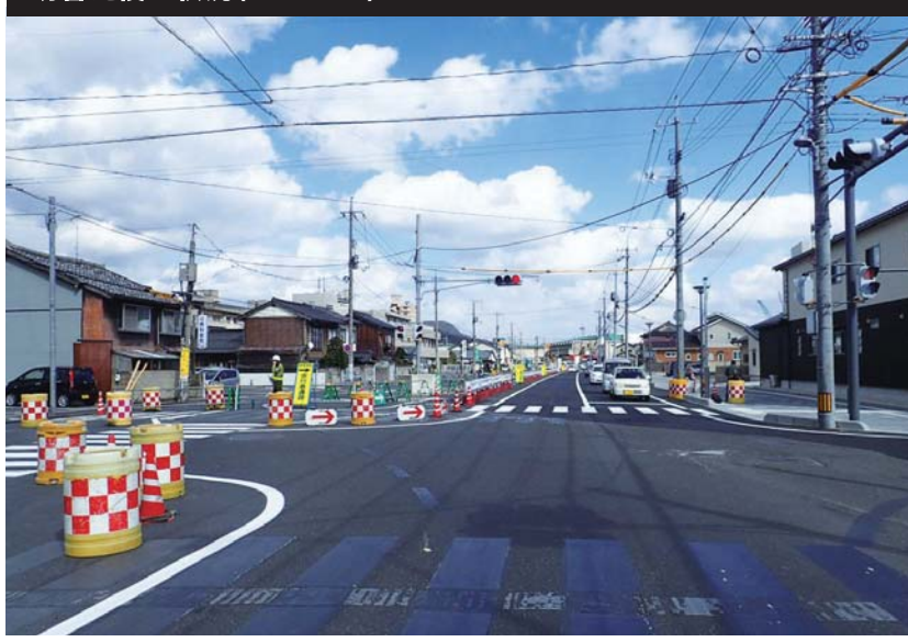
切替え後の状況(H27.3.23)
