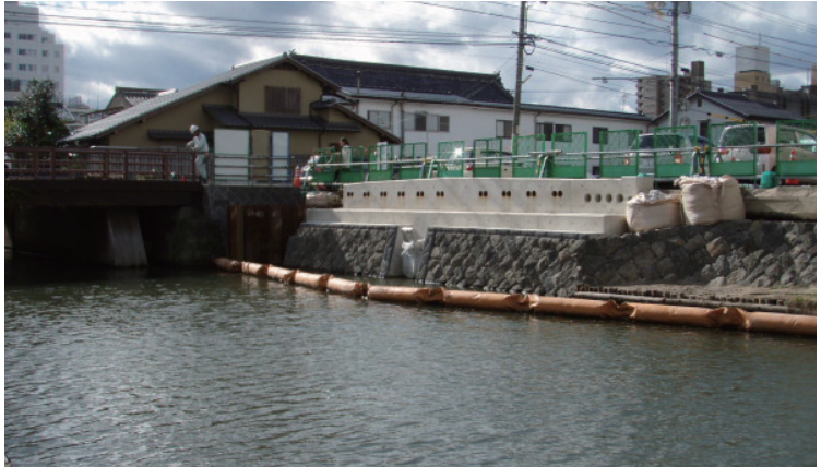
北側橋台部分ができています。
