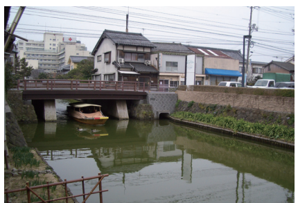
平成20年3月頃の米子橋の様子 米子川は堀川遊覧船の運航ルートです。遊覧船が通過するときには工事を止めるなど、遊覧船の安全確保も行いながら工事を進めていきます。
