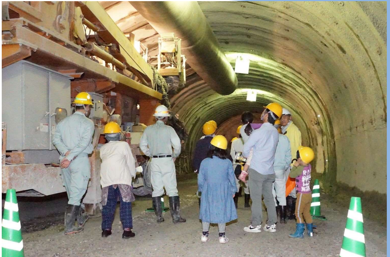
古浦西長江トンネル 現場見学会
