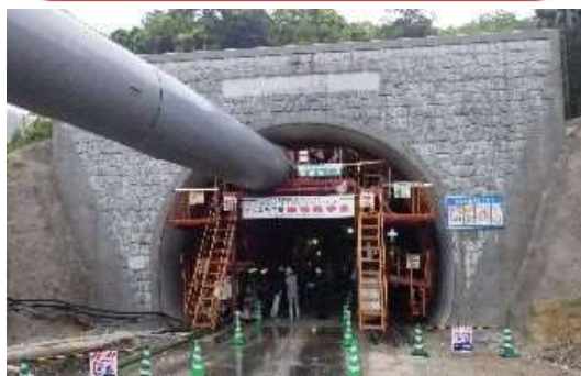
☆現在のトンネル坑口の様子 (坑門が完成しました)
