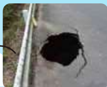
舗装の 陥没
