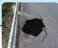
舗装の 陥没
