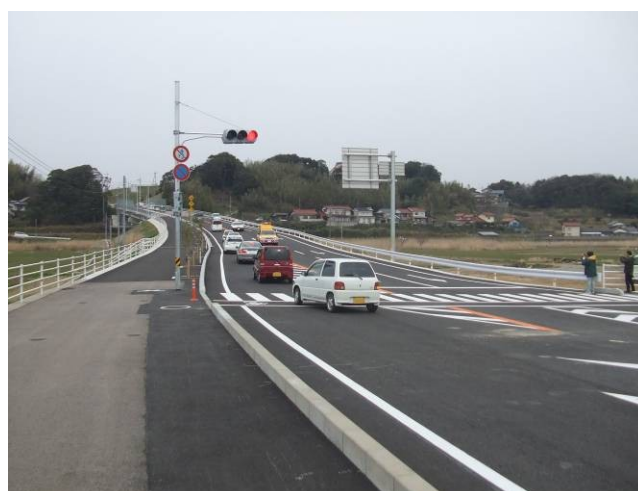
一般県道久城インター線 (市道中吉田久城線との交差点から遠田側をのぞむ)
