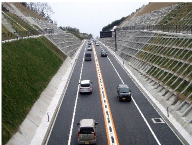
一般国道9号益田道路 (遠田町地内から久城側をのぞむ)
