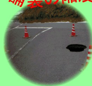
舗装の陥没
