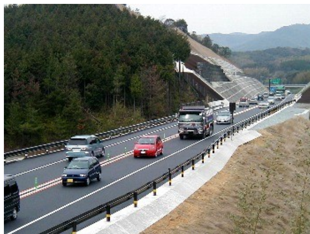
一般国道9号益田道路 (久城町地内から遠田側をのぞむ)
