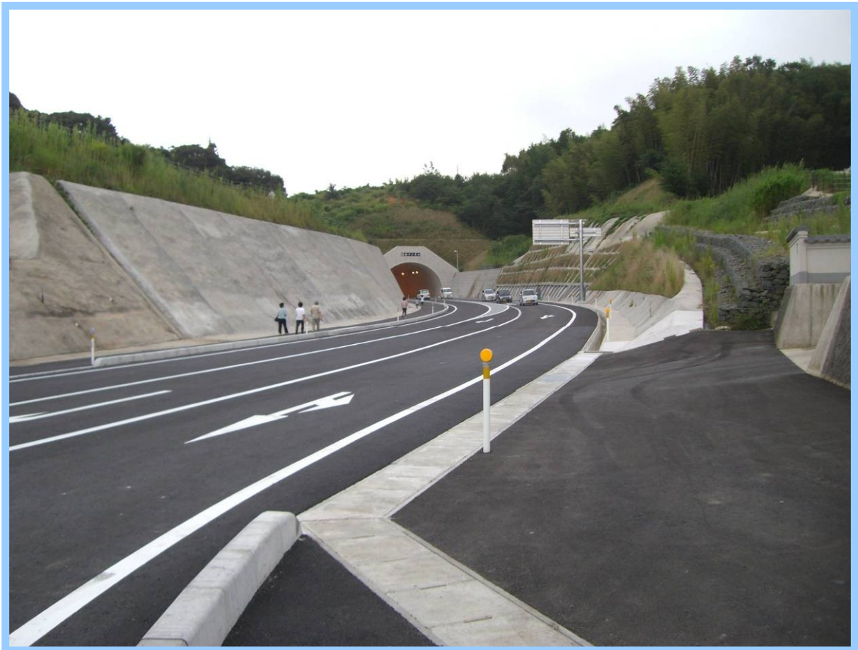
一般県道 浜乃木湯町線（湯町工区） 平成21年8月29日 開通
