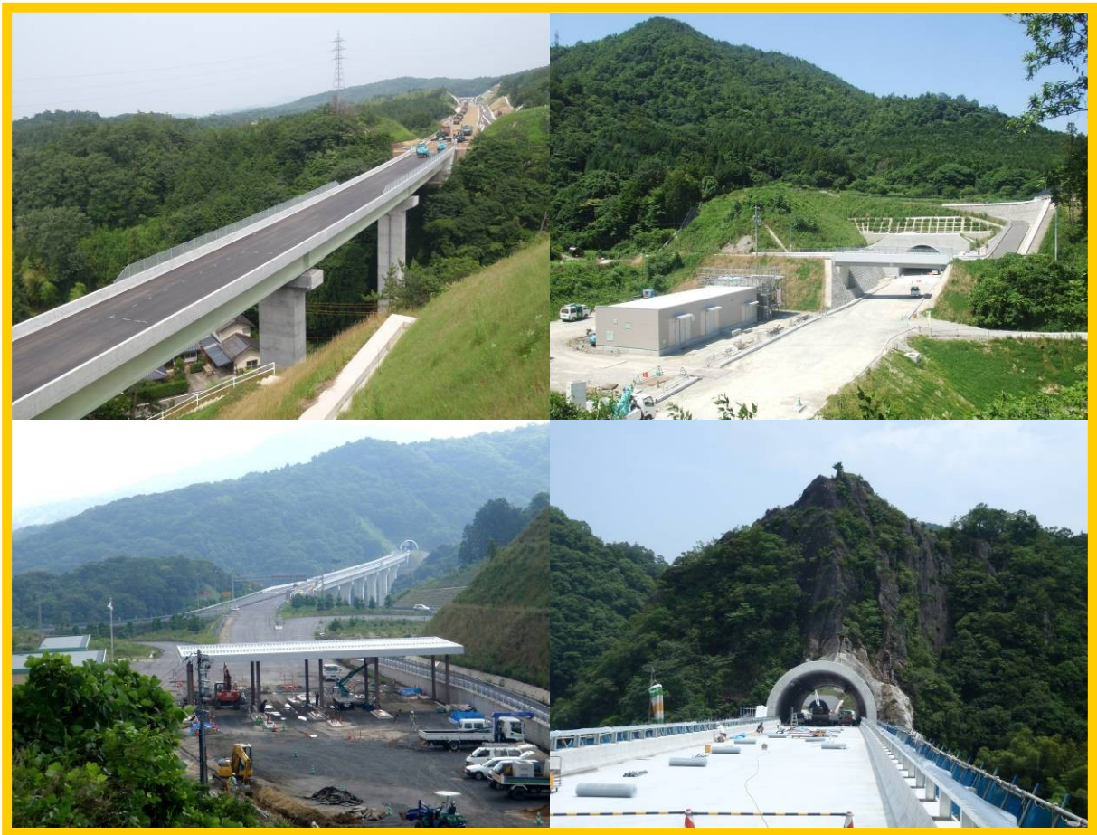
山陰自動車道 斐川出雲間 建設状況
