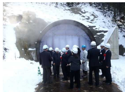
貫通点を通り抜け(広瀬町側にて)
