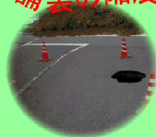
舗装の陥没
