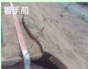
有木線法面对策（着手前・完了）
