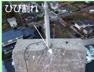
屋那大橋補修（劣化状況）
