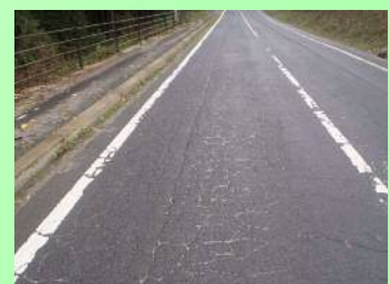
有木線舗装修繕（傷み状況）
