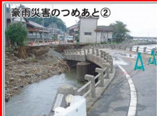
河川増水に伴う護岸洗掘で落橋した寺空橋
