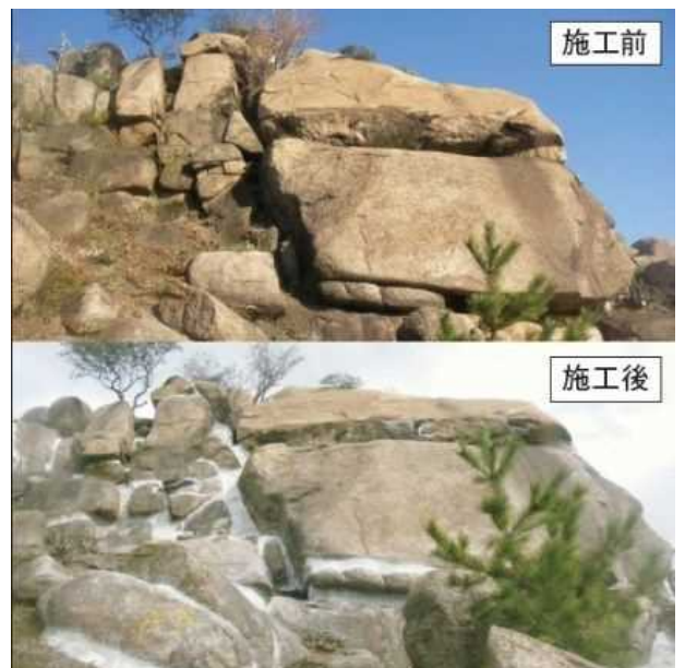
図-10 岩接着工
