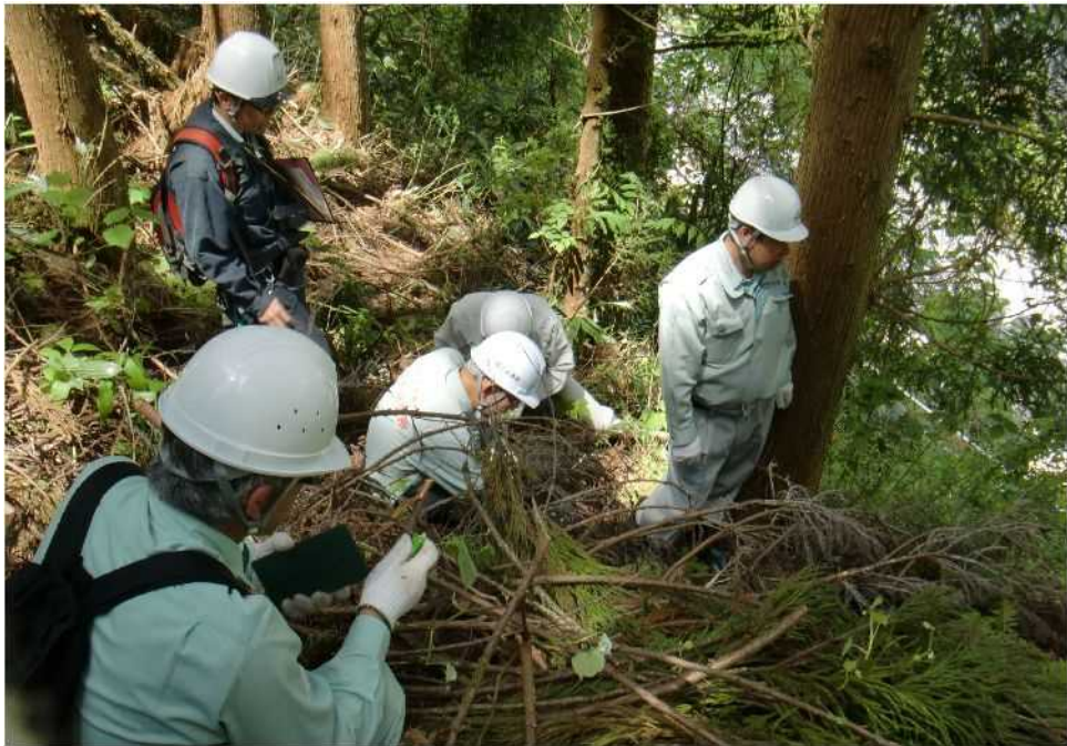
図-4 点検実施状況
