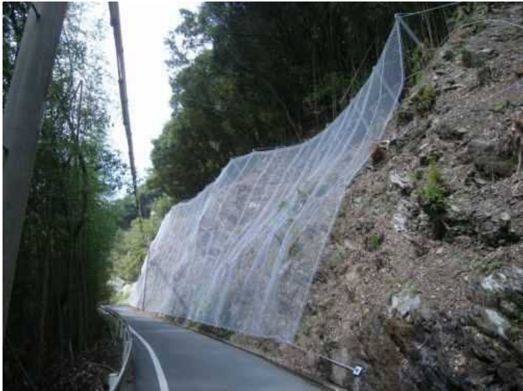
図-8 落石防護網工
