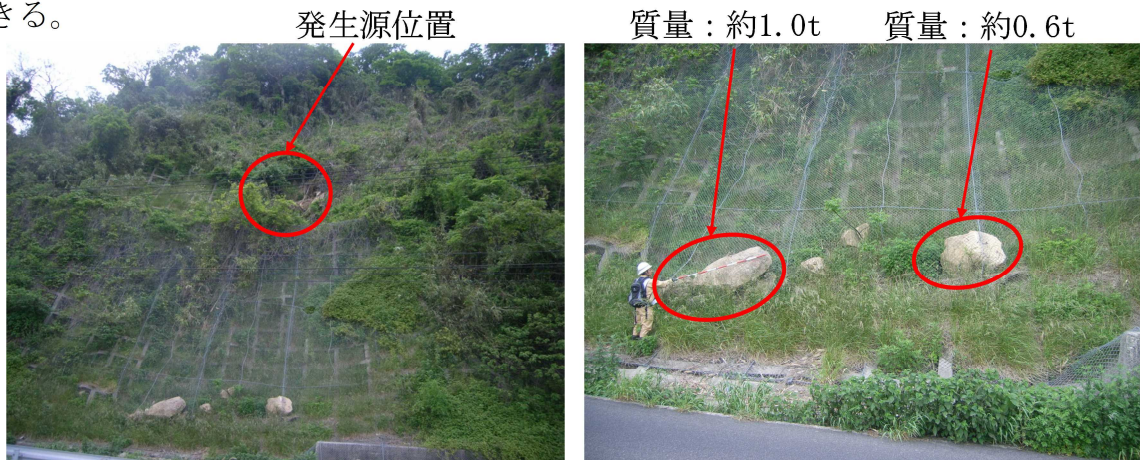
参考図-1 (主) 境美保関線(松江市美保関町男鹿地内)での事例
