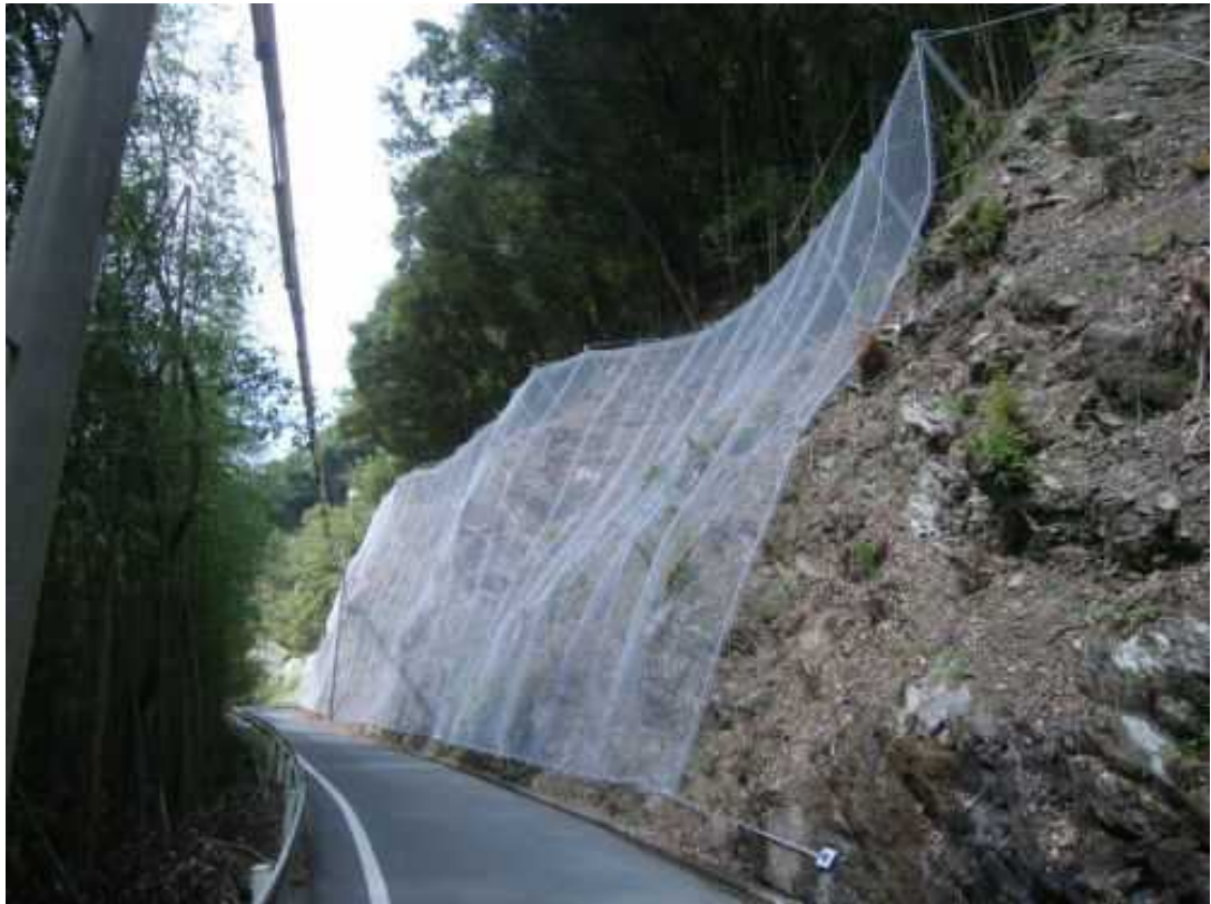
図-7 実施例 (落石防護網)
