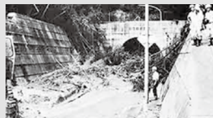
58 豪雨で被災した国道191号人形トンネル＝益田市飯浦町（国土交通省浜田河川国道事務所提供）
