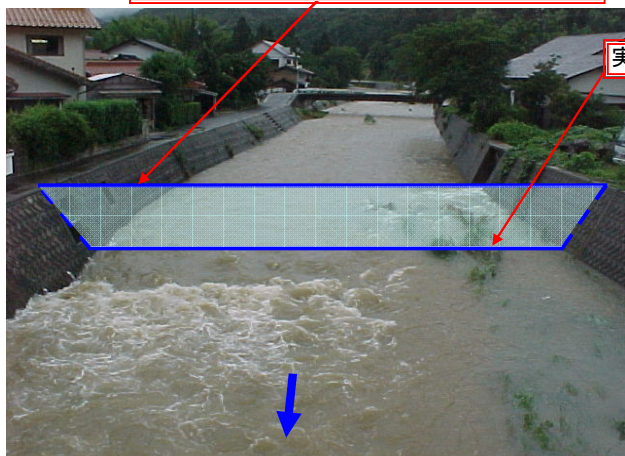
▲ダムの有無によって比較した銚子川水位イメージ図（八尾川との合流点付近）
