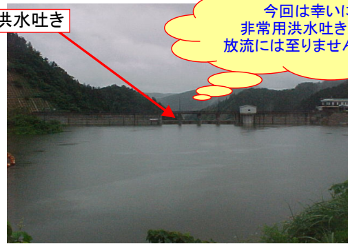
▲貯水池の状況(右奥が管理所)
