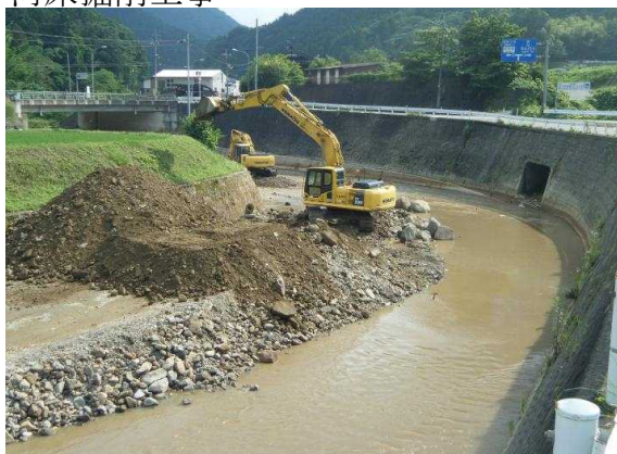
河床掘削工事
