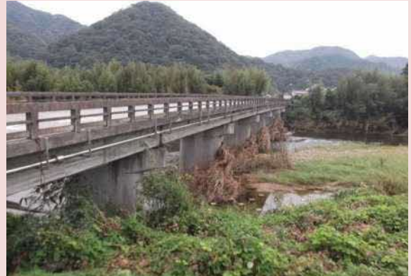
H25.10.1 撮影 江尾橋状況写真
