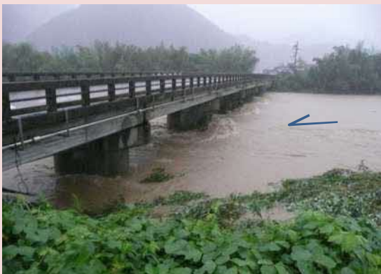
H25.8.24 8時頃撮影 江尾橋状況写真
