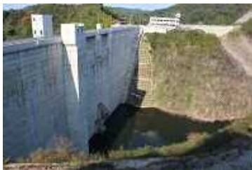
本体ダム上流面
