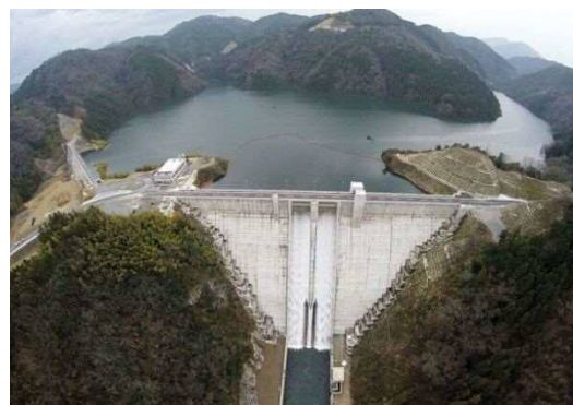
試験湛水時の満水状況〔H28. 2. 1〕
