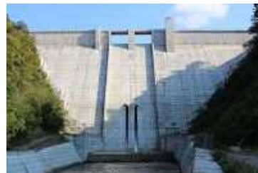
本体ダム下流面
