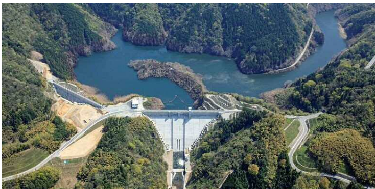
鞍部ダム（左）、本体ダム（右）〔H28. 4〕
