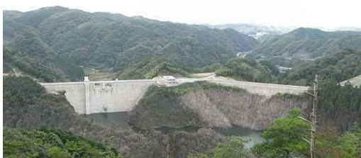
本体ダム（左）、鞍部ダム（右）
