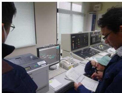
管理所内機器検査状況
