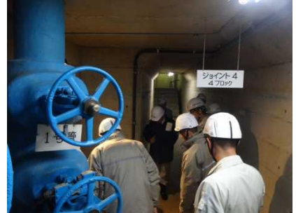
堤体内取水設備点検状況
