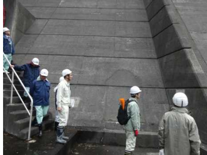
ダム右岸下流点検状況
