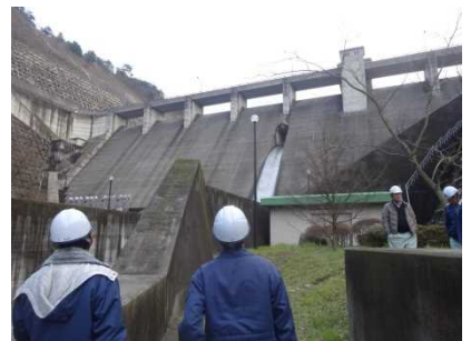
ダム左岸下流より
