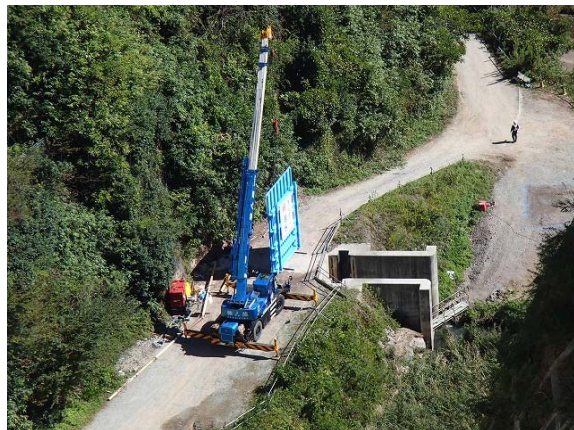
湛水ゲートによる堤外仮排水路の閉塞
