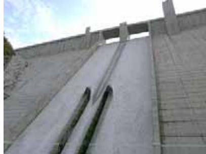
非常用洪水吐からの越流状況 (H28/2/1)
