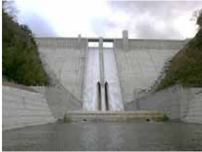
下流側よりダム堤体を撮影 (H28/2/1)
