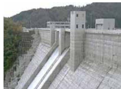
非常用洪水吐からの越流状況 (H28/2/1)
