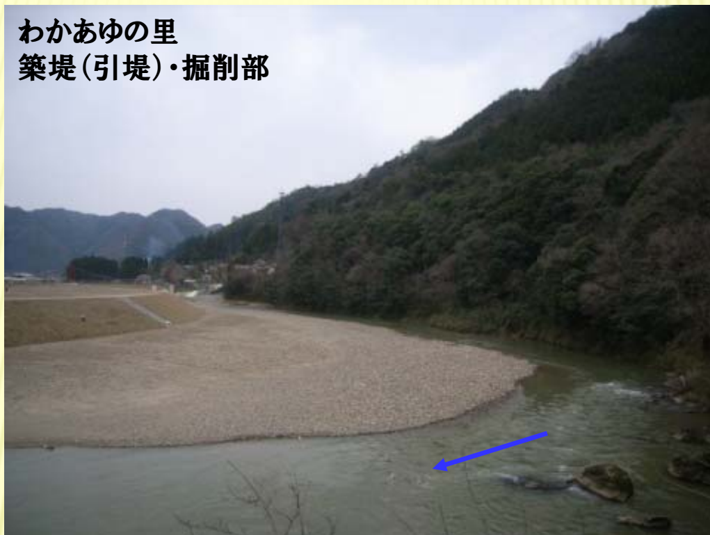
後谷川合流付近樋門施工部 (わかあゆの里対岸)
