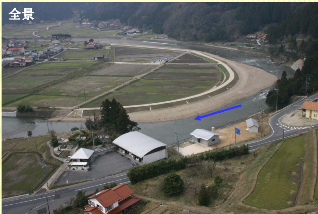
下流右岸側 護岸復旧部
