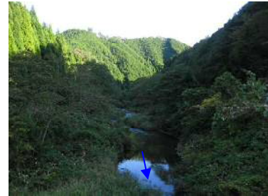
⑥来島ダム下流 (溪谷部)
