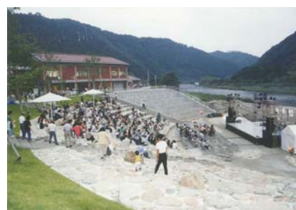
写真 11-2 親水護岸 (高津川)
