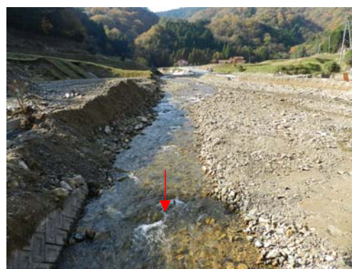
津和野町名賀付近（被災後 H25.11）
