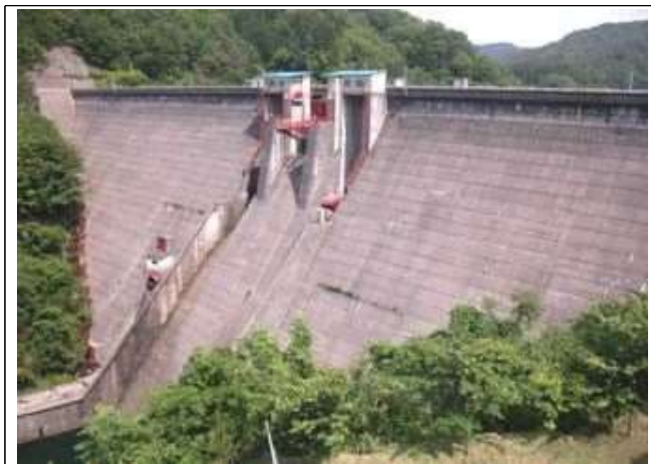
写真 7.4-9 布部ダム（下流面）
