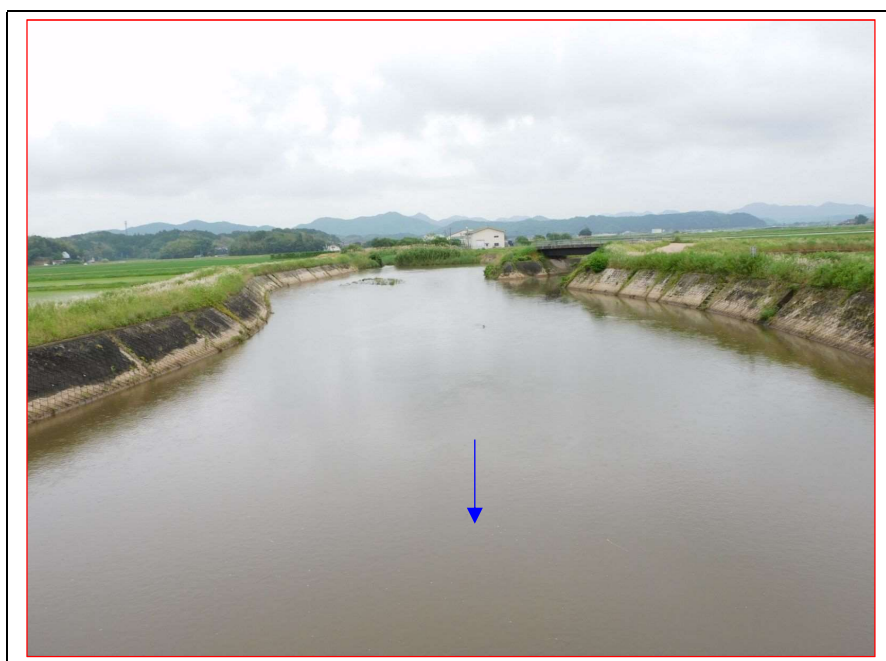
写真 7.4-12 吉田川（瀬崎橋の上流）
