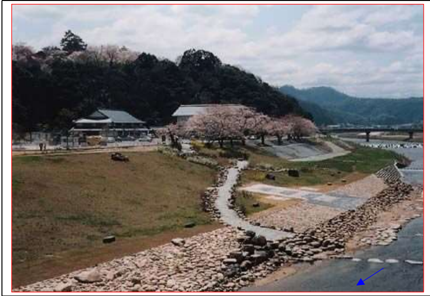
写真 7.4-4 飯梨川（ラブリバー区間）
