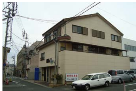
シェアハウス(魚町:尾原ハウス)
