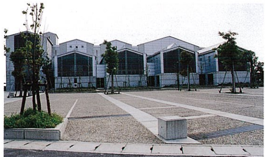
平田市立図書館（平田市） 地域の伝統的な建築形式（妻入住居）と調和した形態
