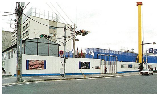
市町村振興センター（松江市） 工事中美装した仮設塀で現場を遮蔽
