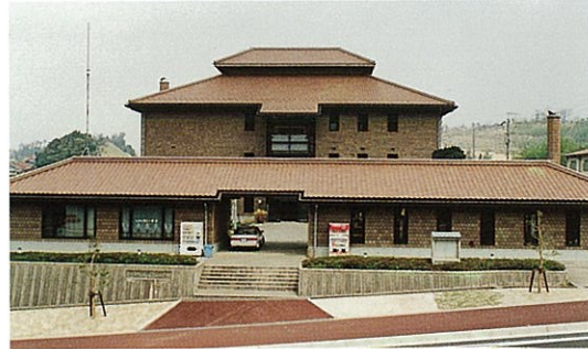
地場産業振興センター（江津市） 地場産の瓦、タイルを外装材に使用
