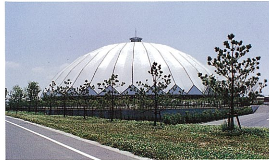
出雲ドーム（出雲市） 木材を用いた大建築物で地域のランドマークとなっている
