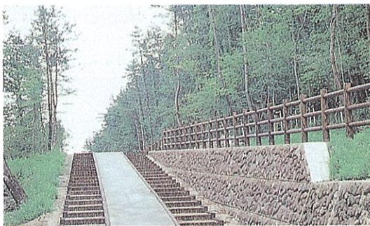
三瓶フィールドミュージアム（大田市） 現地発生の自然石を活用した擁壁
