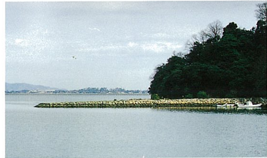
安来港（安来市） 自然石積みの北防波堤
