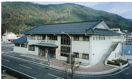
別府港（西ノ島町） フェリーの上屋
