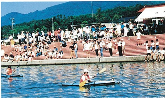
天神親水公園（平田市・平田船川） 背後の公園と調和した緩傾斜護岸毎年カヌーレースを開催
