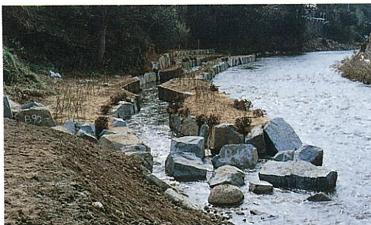
赤川ホテル護岸（大東町） ホテルの成育環境保護
