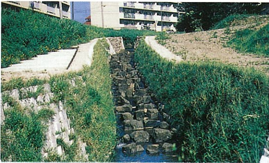
多岐塚川（多伎町） 自然石を用いた斜路、緑化ブロック等を採用した多自然型川づくり
