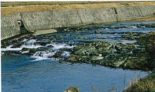
益田川落差工（益田市）
