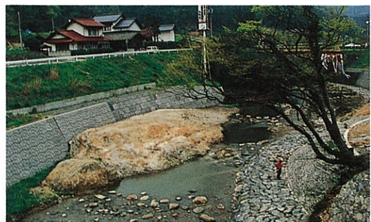
赤川（大東町） 既存の樺を残して護岸にアクセント
