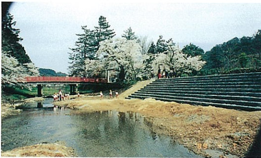
意宇川（八雲村） 熊野大社の厳かなたたずまいと調和した間知石を用いた階段式護岸
