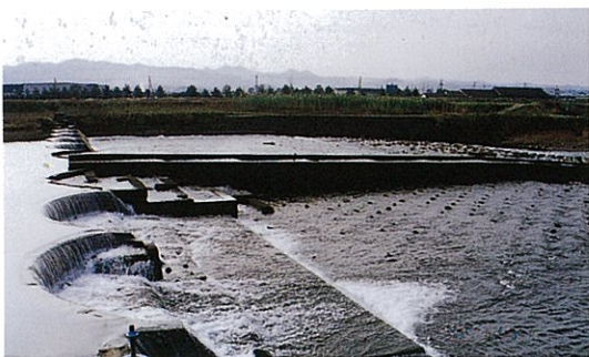
神戸川白枝付近（出雲市） 落差工、魚道工 上下流で水面の変化が豊か
