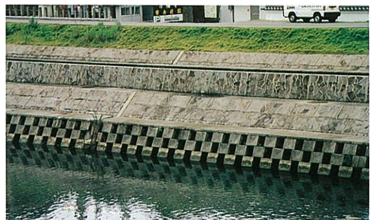
益田川（益田市） まち並みの景観にマッチした地場産の石張（鉄平石）と、護岸下部には魚巢ブロックで魚類へ配慮
