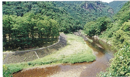
出羽川（羽須美村） 背後のキャンプ場と一体となった階段式緩傾斜護岸の整備
