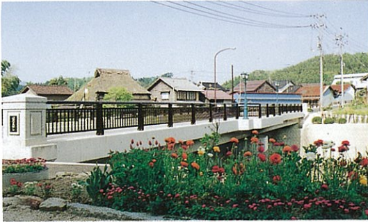
穂多留橋 (横田町) 橋上にバルコニーを設置 親柱、高欄、照明をデザイン化 鉄滓で舗装
