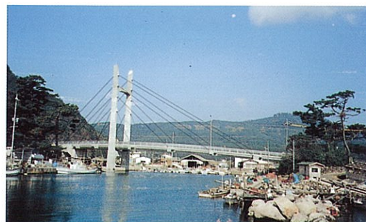
屋那大橋（都万村） 都万村のシンボルタワー
