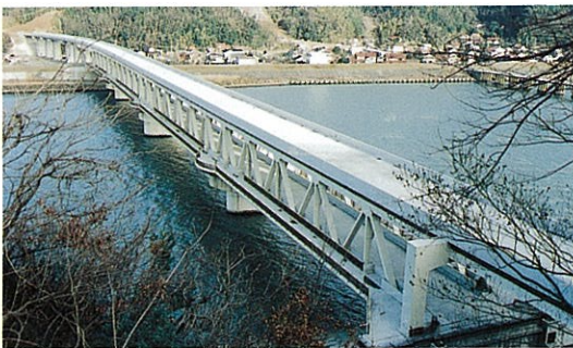
新江川橋（江津市） 委員会を設置して色彩を決定した 又、高欄、舗装に地元特産の瓦を利用した
