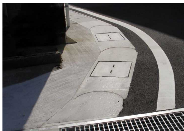
施工後(曲線部全景)
