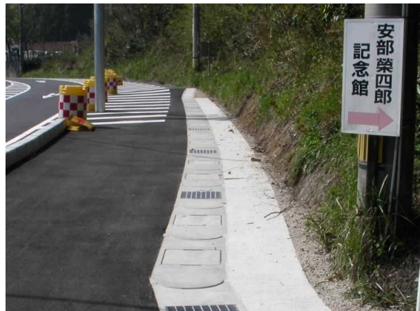
施工後(曲線部全景) カーブ曲線がソフトで綺麗に仕上がっている
