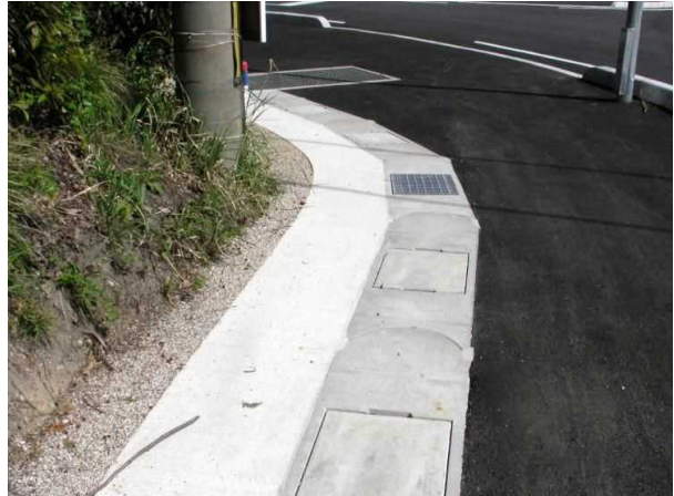
施工後(コーナー部全景)
